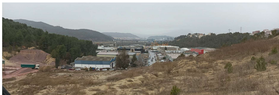
Vista nord est
