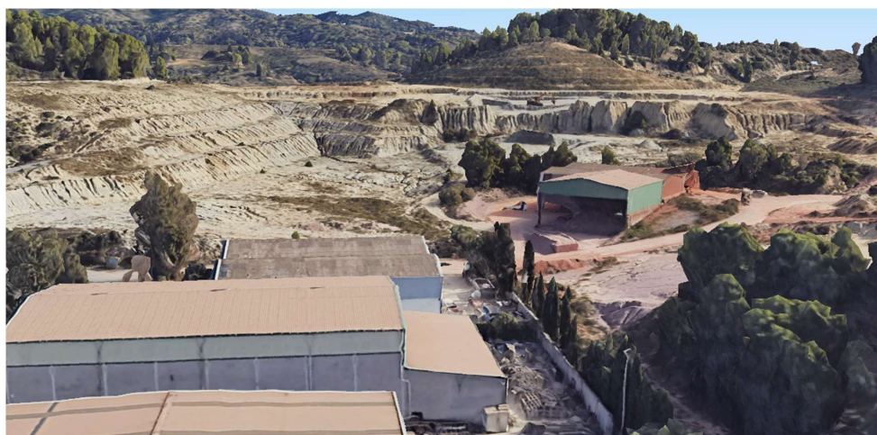
Vista sud est
