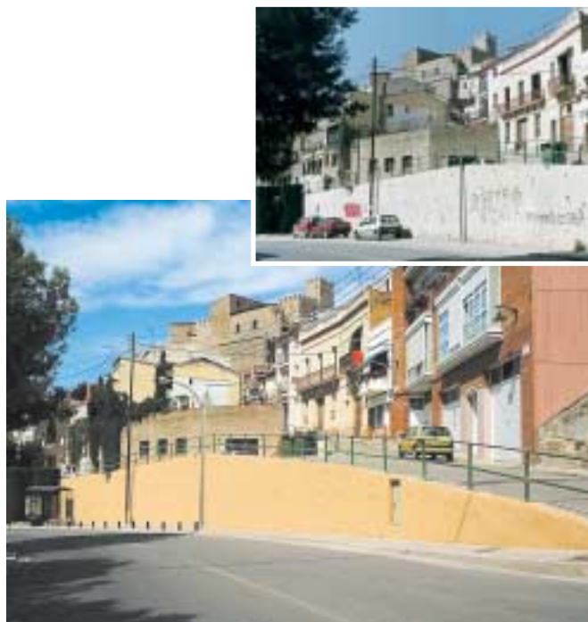
El mur abans i després de la restauració
