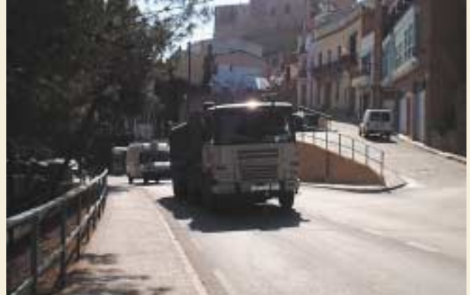
El Consistori està desenvolupant el projecte del traçat provisional que utilitzaran els camions durant les obres
