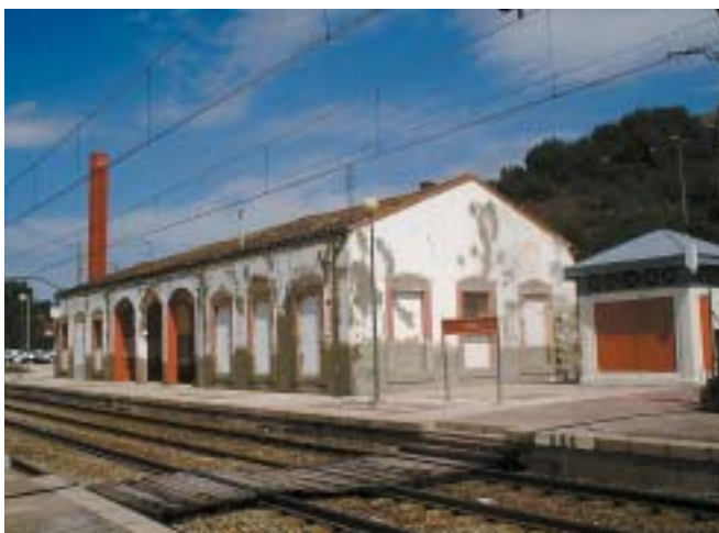
Obres a la façana de l'edifici
