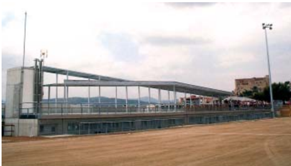
Vista general de l'edifici
